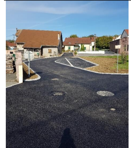
Travaux réalisés à Laire
